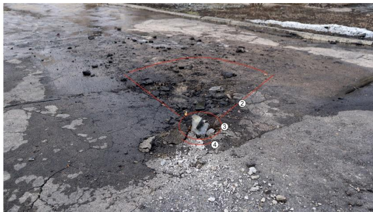
Рис. 58 – Определение типа воронки на примере попадания № 22 (слева: схема воронки, образовавшейся после детонации снаряда, соприкоснувшегося с поверхностью под большим углом встречи 45 ; справа: воронка на месте попадания № 22).
