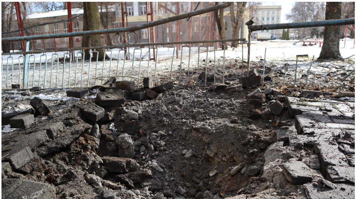
Рис. 41 – Попадание снаряда в тротуарное покрытие между территорией Свято-Преображенского собора и спортивной площадкой школы № 2 по ул. Артема, 129 «а».
