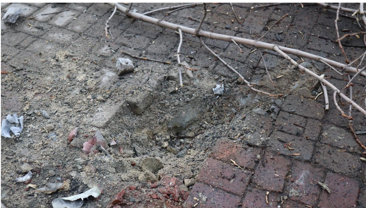
Рис. 51 – Попадание снаряда на тротуарное покрытие возле здания по бул. Шевченко, 9 «а».
