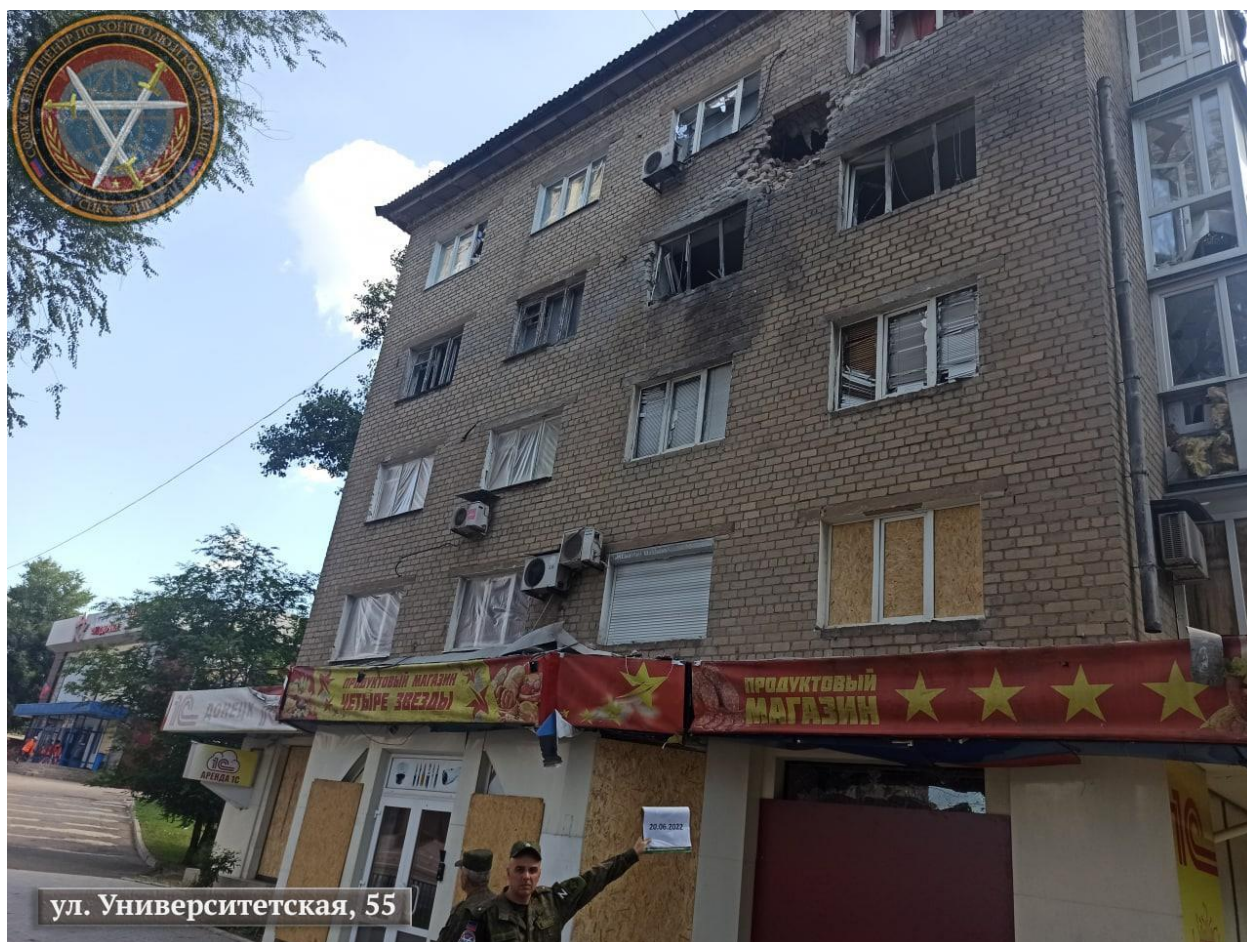
Рис. 15 - Последствия попадания снаряда в стену дома по адресу ул. Университетская, д. 55. 26
