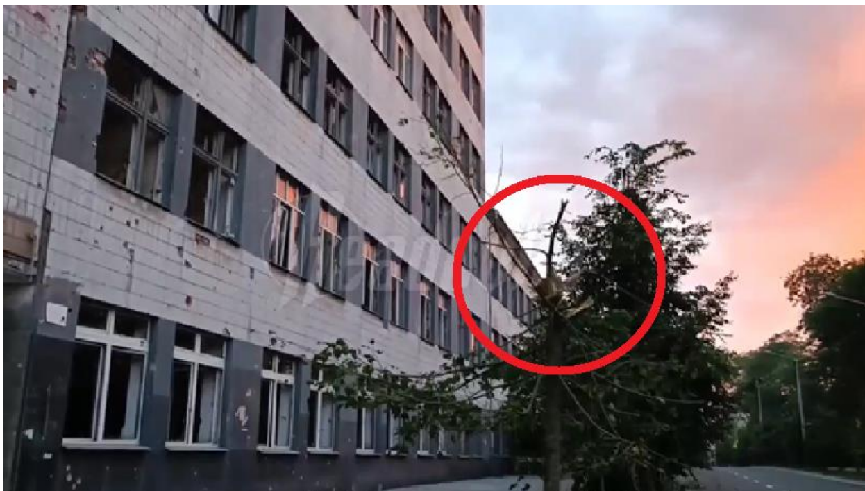
Рис. 5 - Последствия детонации снаряда по улице Ватутина. 17
