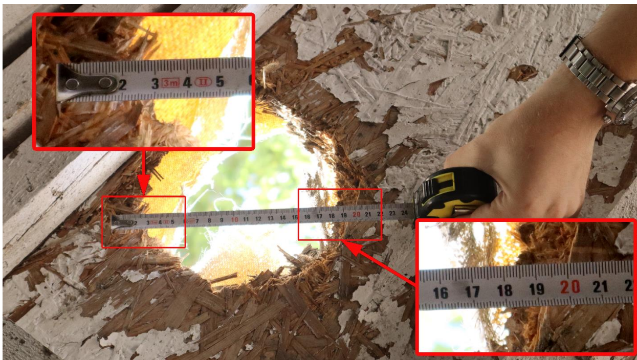
Рис. 20 - Измерение диаметра отверстия в крыше на месте попадания №11.
