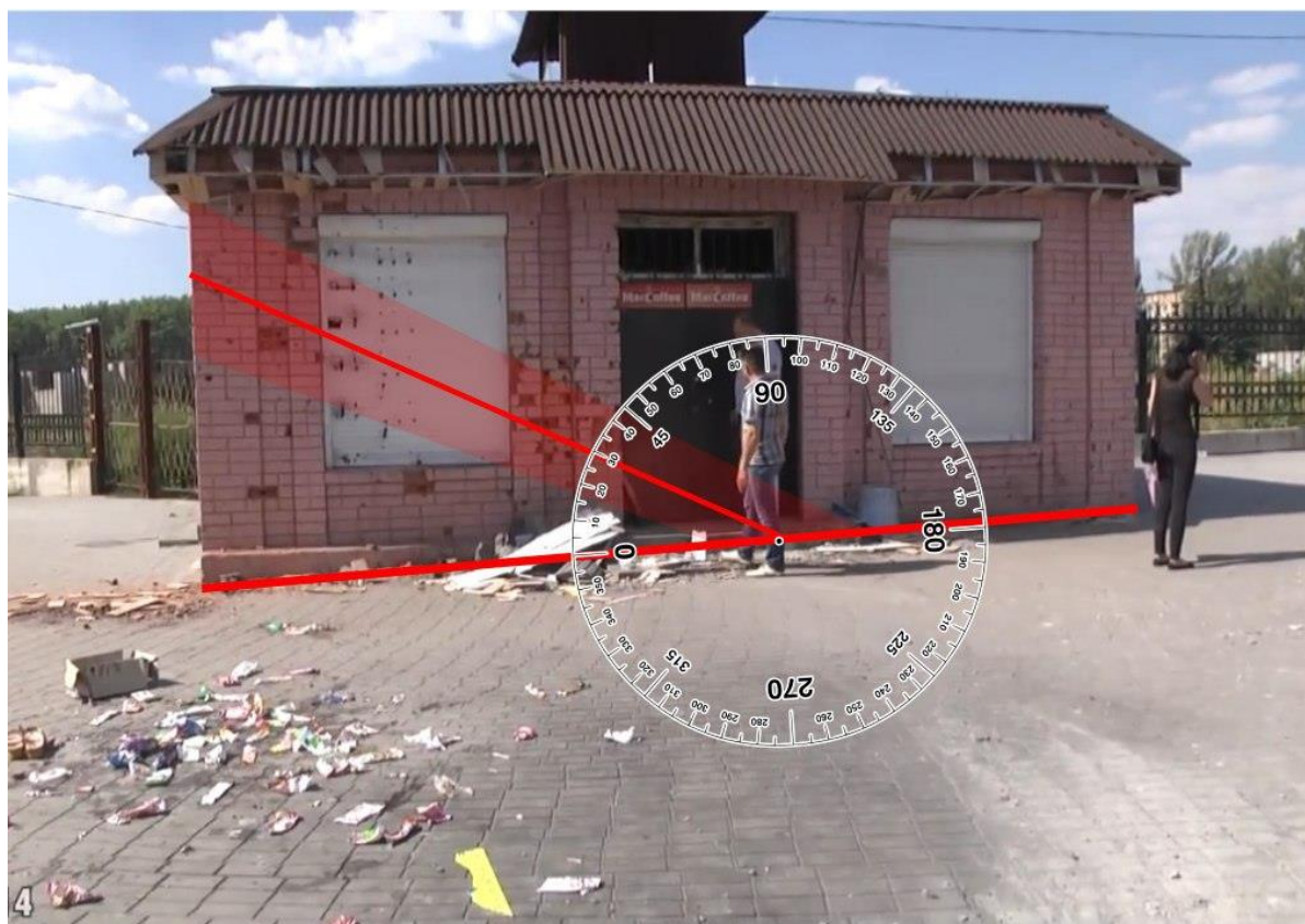
Рис. 28 - След от основного потока разлёта осколков на стене магазина «Кошелёк».
