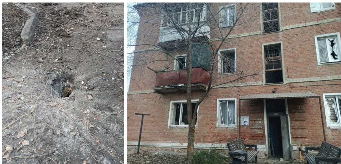
Рис. 4 - Попадание по адресу 2й Котлозаводский переулк, дом 2. 18
