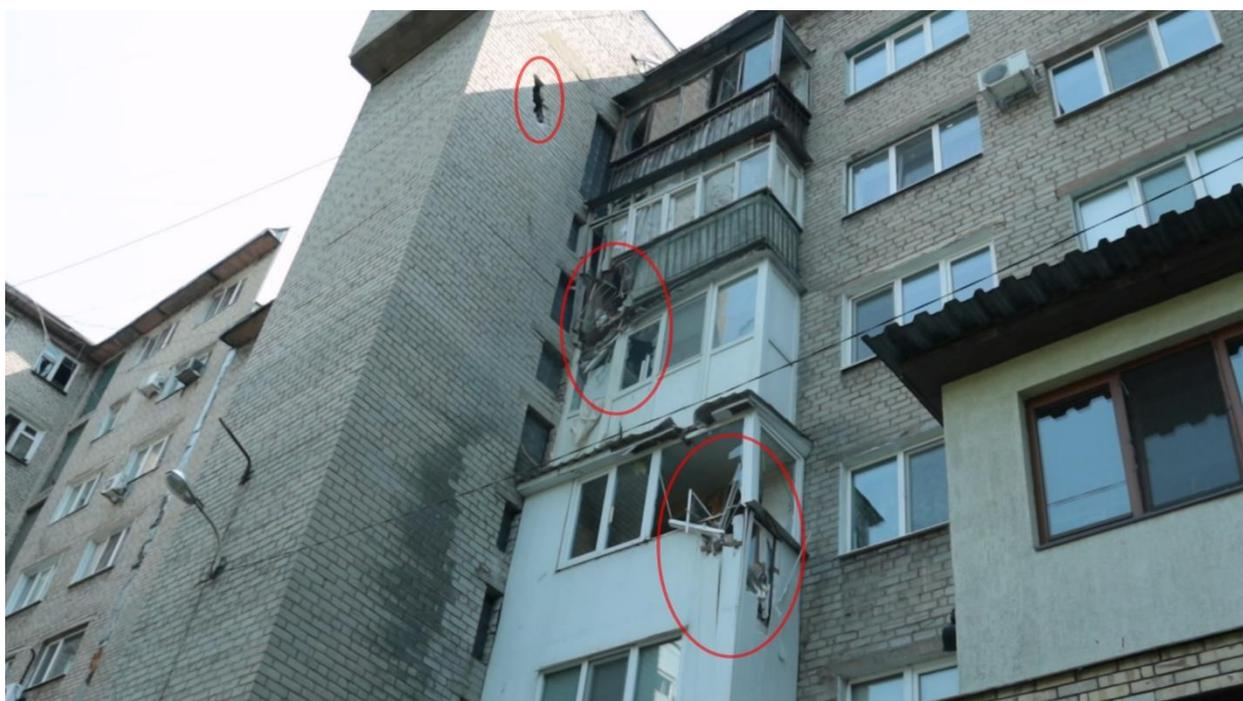
*Рис. 3 – Повреждения стены дома по адресу пл. Конституции, д. 4.*
