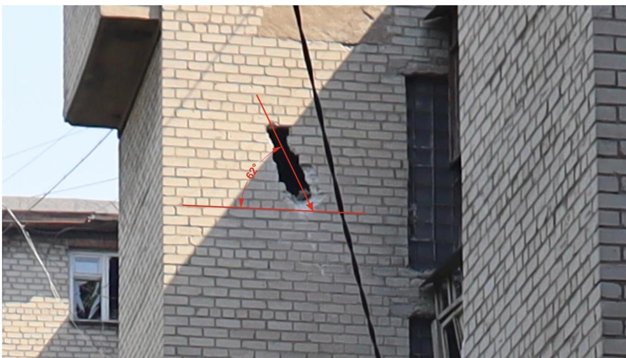
Рис. 26 – Определение угла встречи снаряда с горизонтальной поверхностью.
