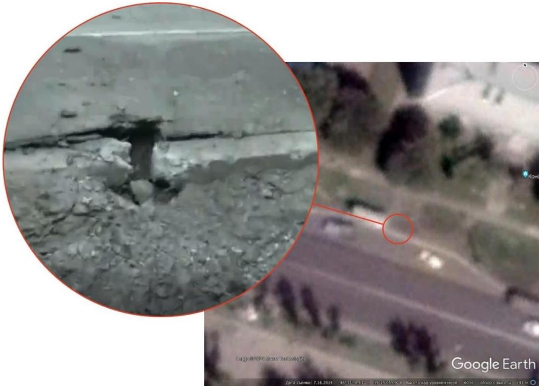
Рис. 43 – Попадание № 10: след от основного потока разлёта осколков с северной стороны от бордюрного камня<sup>51</sup>.
