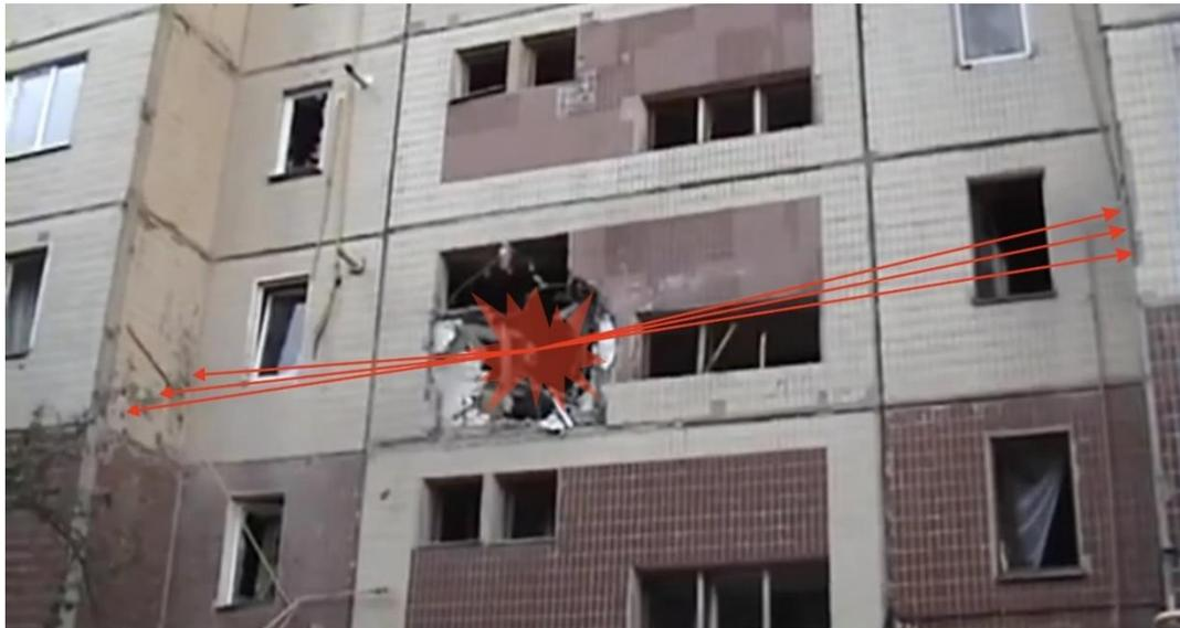
Рис. 38 – Схема разлёта основного потока осколков (попадание № 4)<sup>48</sup>.
