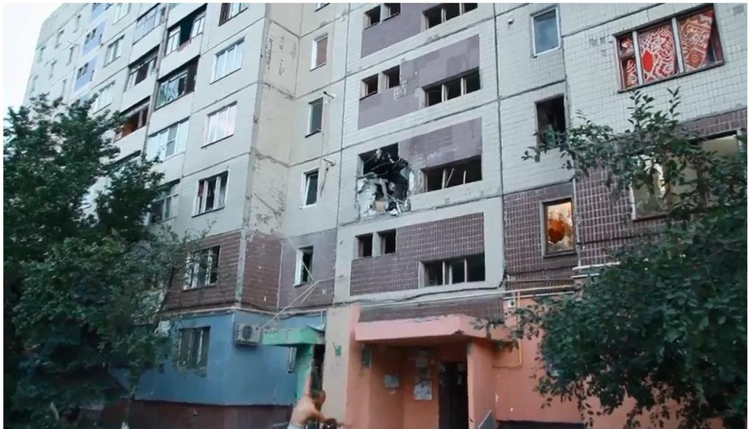
*Рис. 10 - Отверстие, образовавшееся в результате детонации снаряда в северной стене многоэтажного жилого дома по адресу г. Луганск, Ольховский квартал, д. 16, на уровне третьего этажа<sup>22</sup>*
