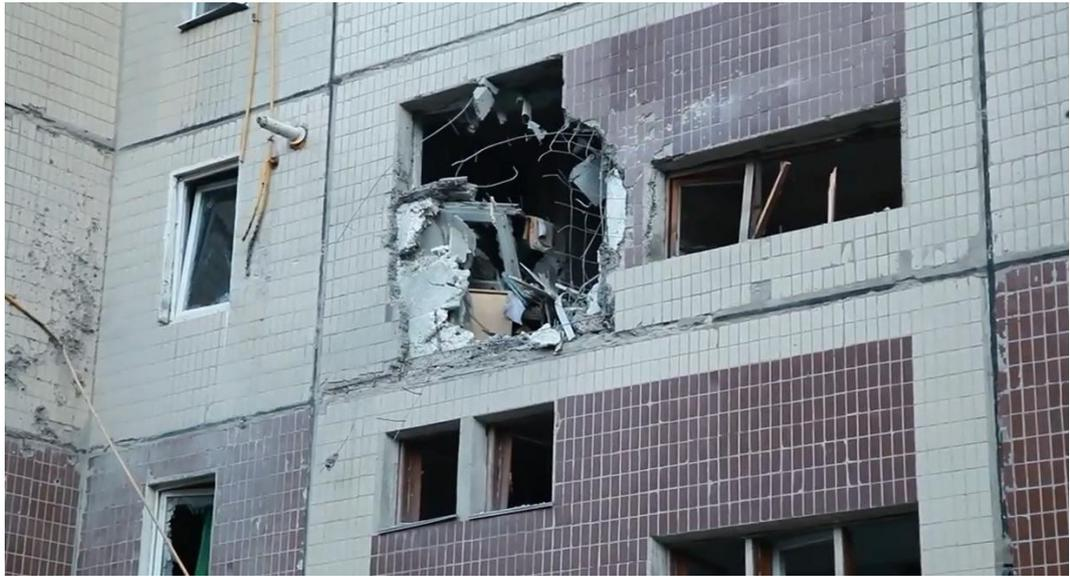
*Рис. 9 – Отверстие, образовавшееся в результате детонации снаряда в северной стене многоэтажного жилого дома по адресу г. Луганск, Ольховский квартал, д. 16, на уровне третьего этажа<sup>21</sup>.*
