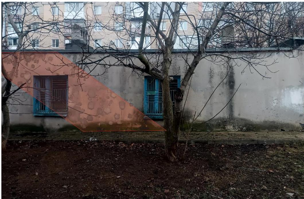
*Рис. 27 – Следы от основного потока разлёта осколков на стене к юго-западу от попадания № 2 (снимок от 12 февраля 2022 года).*
