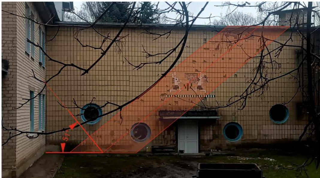
*Рис. 24 – Определение угла падения снаряда по следу от основного потока осколков на стене здания учебно-воспитательного комплекса № 16.*
