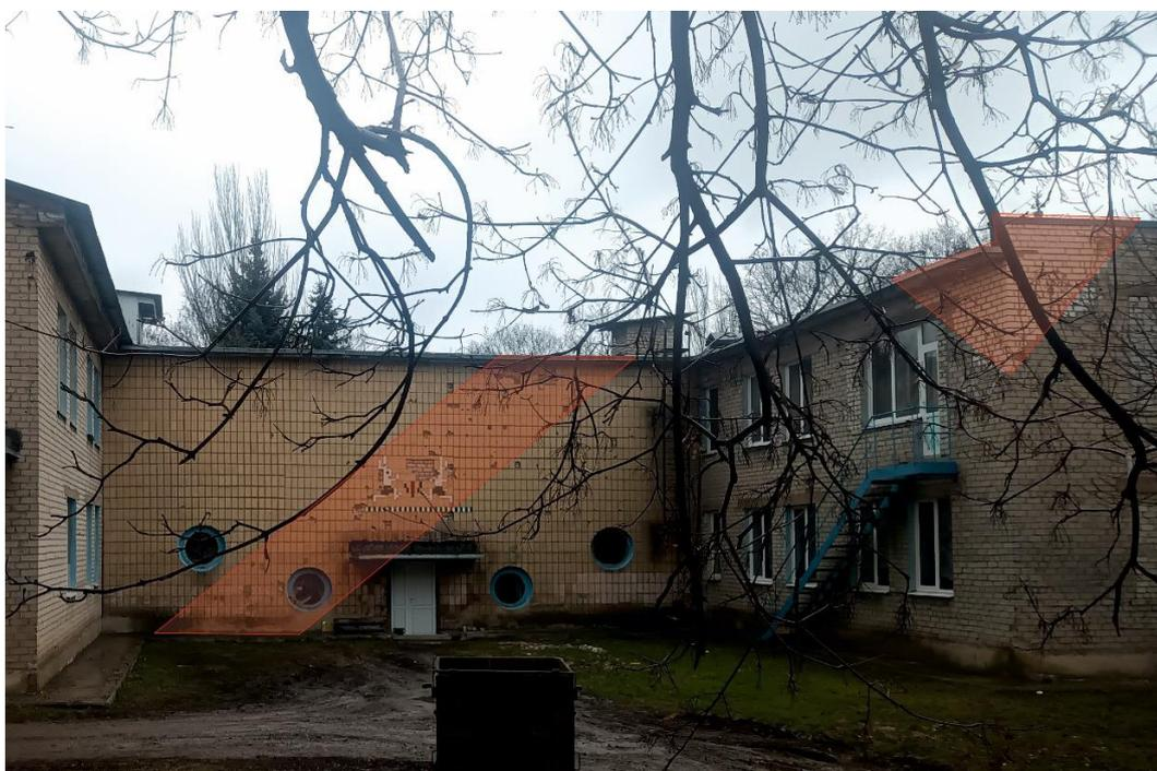
*Рис. 28 – Следы от основного потока разлёта осколков на стене к северо-востоку от попадания № 2 (снимок от 12 февраля 2022 года).*
