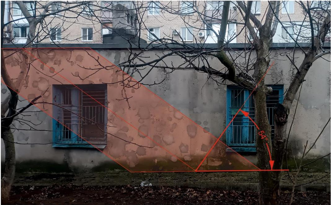
Рис. 25 – Определение угла падения снаряда по следу от основного потока осколков на стене гаража учебно-воспитательного комплекса № 16.
